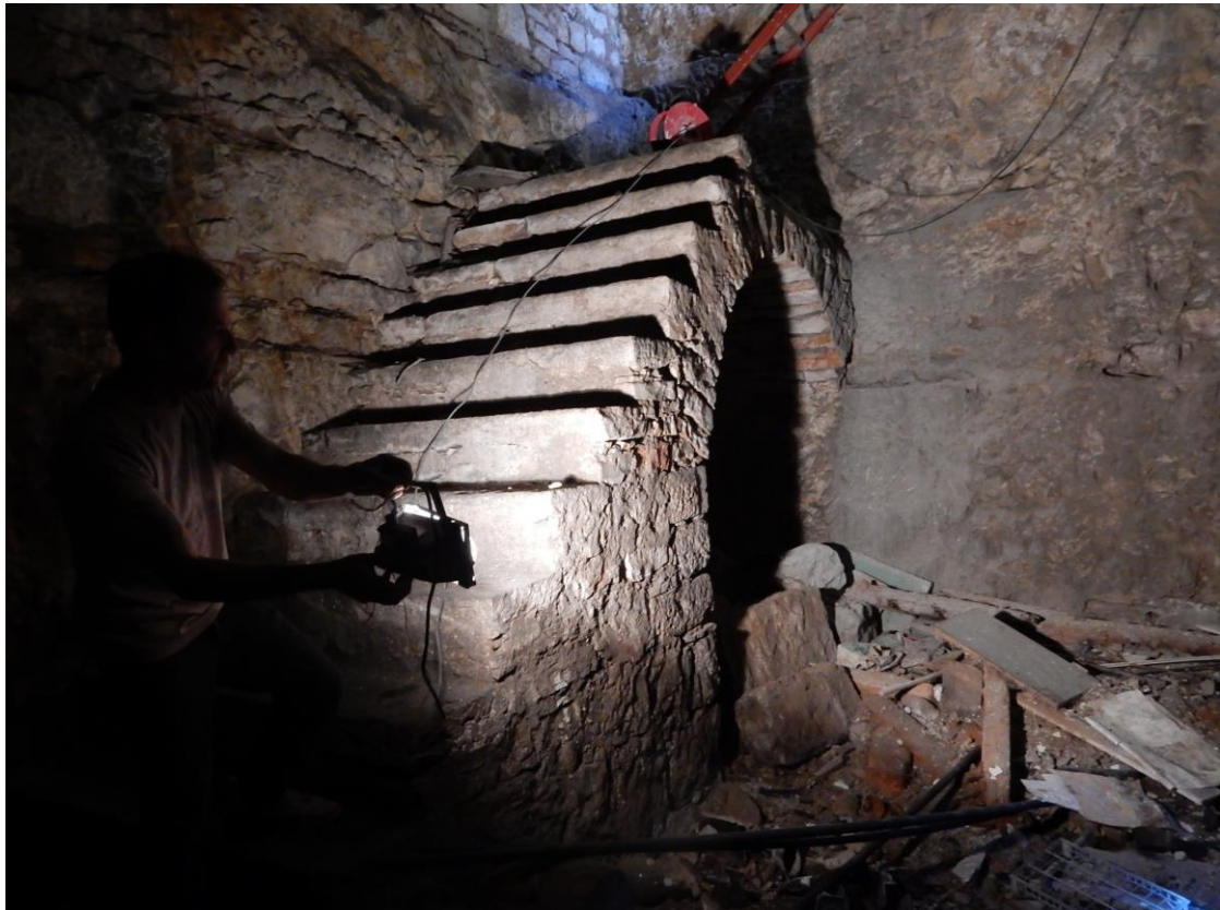
Foto 21: locale ipogeo non oggetto di intervento
