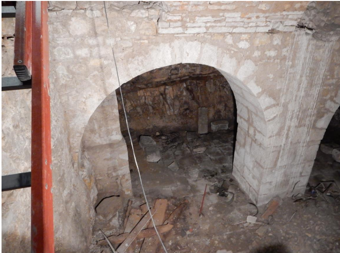
Foto 19: locale ipogeo non oggetto di intervento
