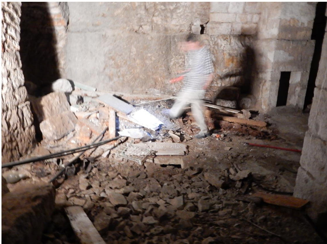
Foto 22: locale ipogeo non oggetto di intervento
