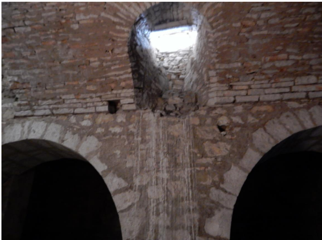
Foto 20: locale ipogeo non oggetto di intervento
