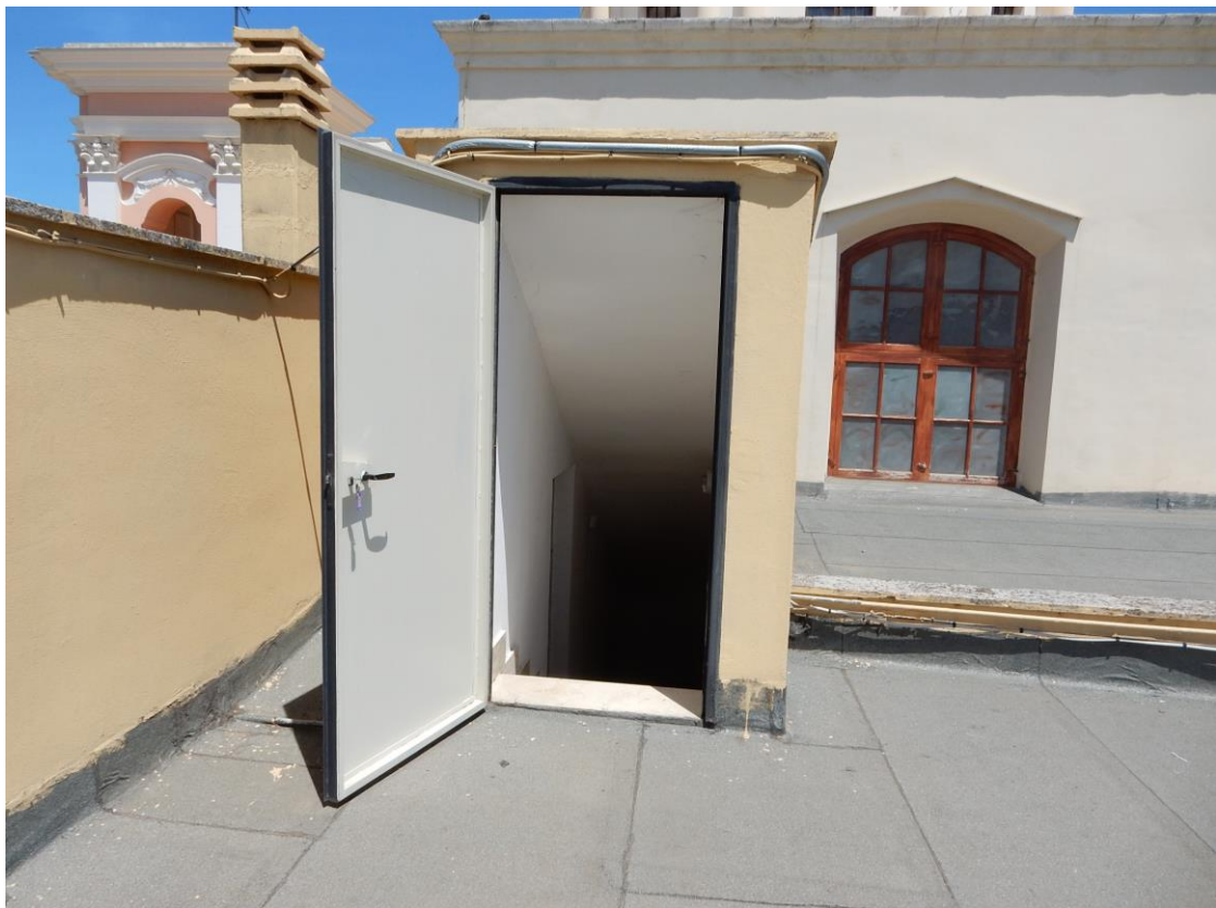
Foto 18: accesso copertura da primo piano scuola
